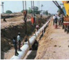
एचबीजे पाइपलाइन को लोयरींग करना Lowering of HBJ Pipeline
